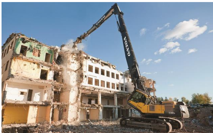
Рисунок 3. – Демонтажный экскаватор
