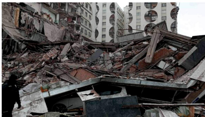
Рисунок 1 – Разрушения в результате землетрясения в Турции
