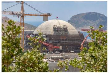
128 выполнено натяжение пучков арматурных канатов. Из них 68 натянуто горизонтально вертикально. 60 Для натяжения стальных канатов применялись гидравлические домкраты. Усилие натяжения каждого пучка составило порядка 1200 тонна-сил.
