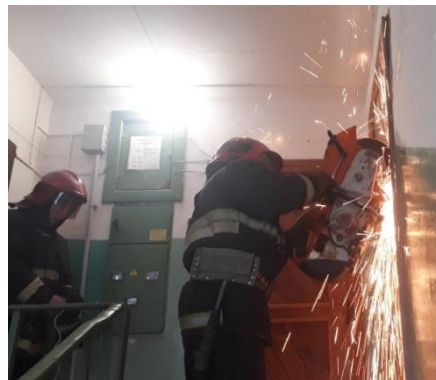
Рисунок 1. – Операции по резке элементов входной двери
